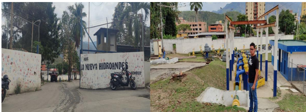
Figura 1. Visita a la subestación de Bombeo Santo Domingo Hidroandes
