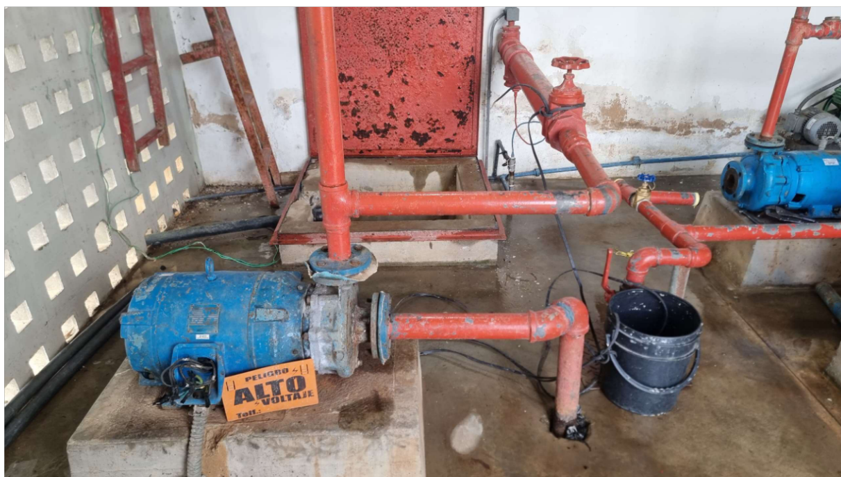
Anexo 4. Bomba de emergencia para los bomberos
